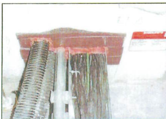
Figura 6.4 – Vedação de cabos em passagem de parede. Fonte: HILT
