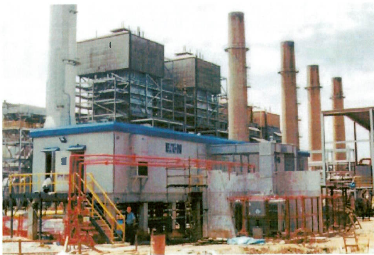
Figura 4.4 – Eletrocentro montado próximo ao centro de cargas. Fonte: EATON
