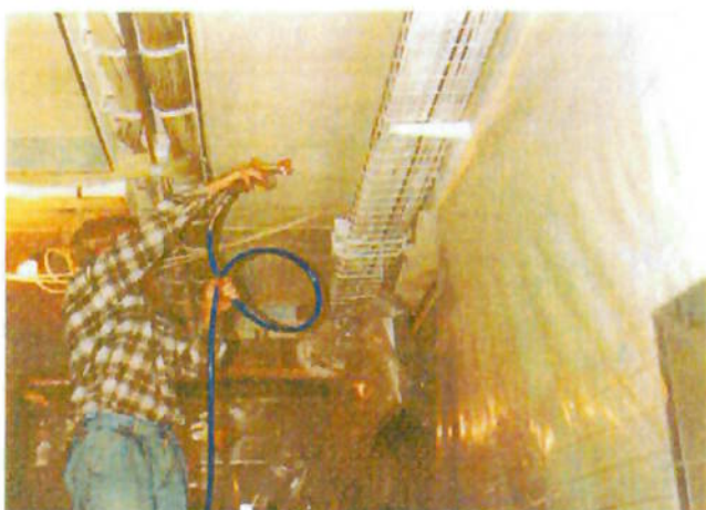
Figura 6.1 – Aplicação de pintura intumescente. Fonte: HILT
