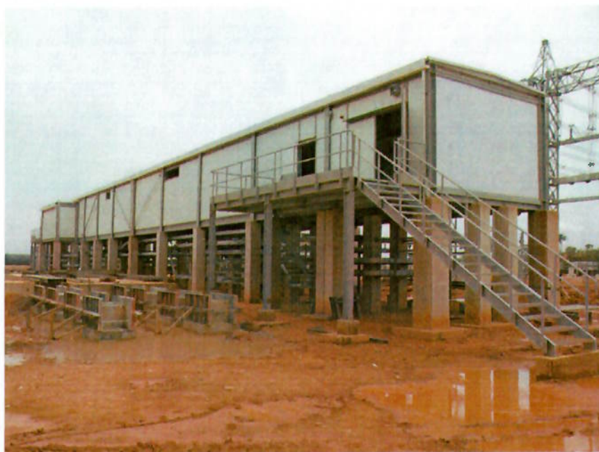
Figura 5.1 – Eletrocentro para subestação. Fonte: EMERSON
