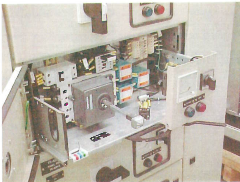
Figura 6.9 – Gaveta compartimentada de um CCM. Fonte: LAVILL
