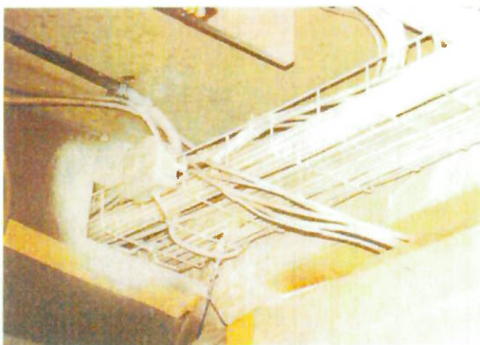
Figura 6.2 – Pintura intumescente em leito de cabos. Fonte: HILT
